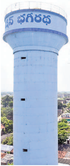
పరకాలలో ప్రారంభానికి సిద్ధమైన మిషన్ భగీరథ వాటర్ ట్యాంక్
