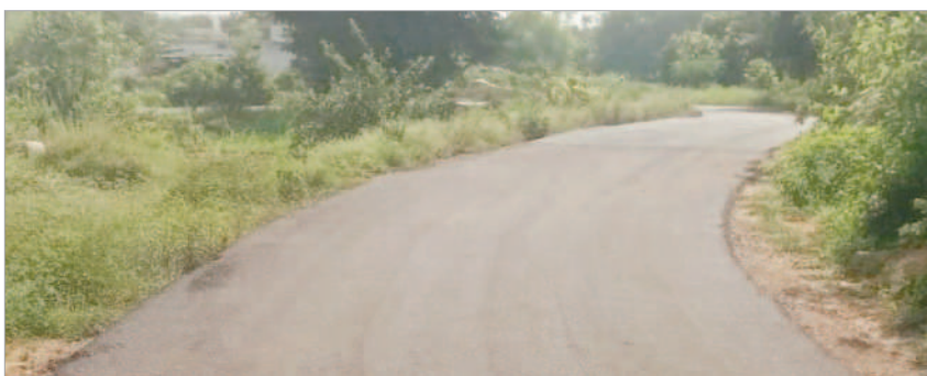
పుట్టినిపల్లి తండాకు నూతనంగా నిర్మించిన బీటీరోడ్డు
