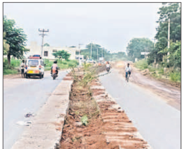
ఏఎస్ ముందు నుంచి వడ్డెర కాలనీ వరకు నిర్మించిన డివైడర్
