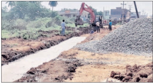
బీర్హూర్ మండలంలో కొనసాగుతున్న డ్రైనేజీ నిర్మాణ పనులు
