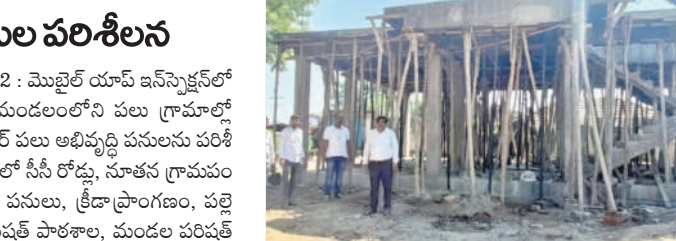
జీపీ భవన నిర్మాణ పనులు పరిశీలిస్తున్న ఎంపీడివో
