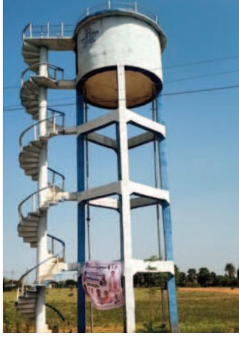
గుర్రపుతండాలో నిర్మించిన మిషన్ భగీరథ ట్యాంకు
