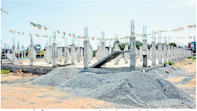
వరంగల్ లక్షీపురం వద్ద నిర్మిస్తున్న ఇంటిగ్రేటెడ్ వెజ్ అండ్ నాన్ వెజ్ మార్కెట్
