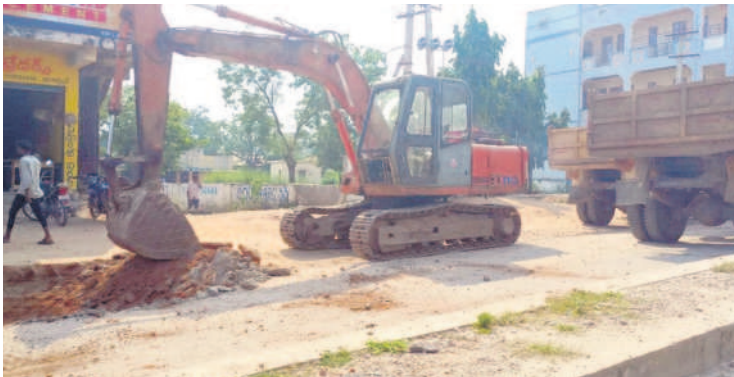
ఖానాపూర్ లో కొనసాగుతున్న రోడ్డు విస్తరణ పనులు
