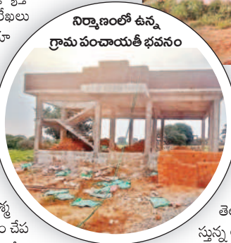
నిర్మాణంలో ఉన్న గ్రామ పంచాయతీ భవనం
