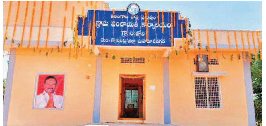
నూతనంగా నిర్మించిన రాజోళి గ్రామ పంచాయతీ భవనం
