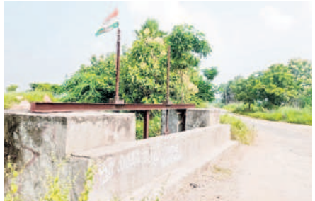
గుండెపూడి రహదారిలో తొలగించని కాంగ్రెస్ పార్టీ జెండా
