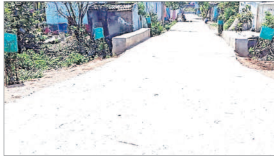
గ్రామంలో ఇటీవల నిర్మించిన సీసీ రోడ్డు
