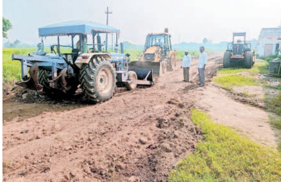
కొనసాగుతున్న రోడ్డు నిర్మాణ పనులు
