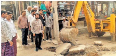
సీసీ రోడ్డు పనులను పర్యవేక్షిస్తున్న కౌన్సిలర్ హసన్ షా
