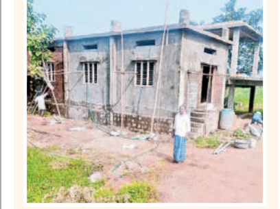
కొనసాగుతున్న భవన నిర్మాణ పనులు
