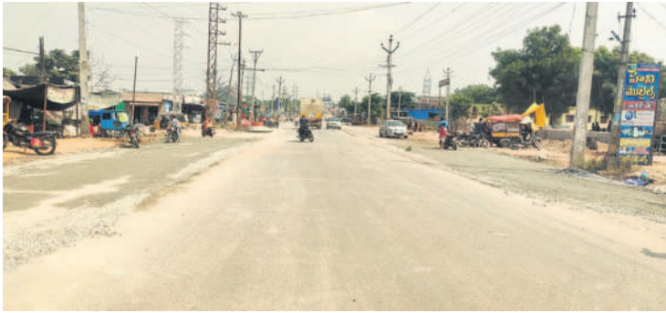
రామన్నపేటలో జరుగుతున్న రోడ్డు విస్తరణ పనులు
