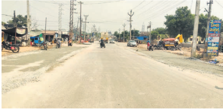
రామన్నపేటలో జరుగుతున్న రోడ్డు విస్తరణ పనులు
