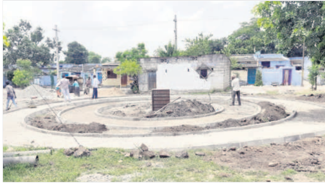
సుభాష్ నగర్లో కొనసాగుతున్న బతుకమ్మ ఘాట్ నిర్మాణ పనులు
