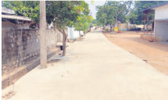
గ్రామంలో ఇటీవల నిర్మించిన సీసీ రోడ్డు
