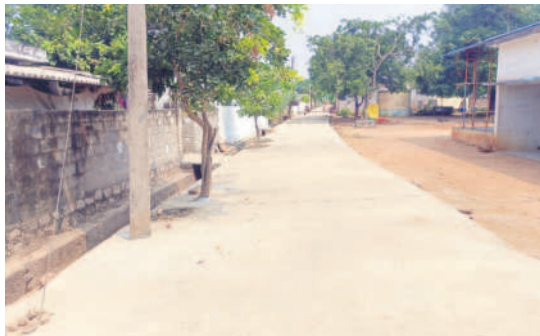
గ్రామంలో ఇటీవల నిర్మించిన సీసీ రోడ్డు
