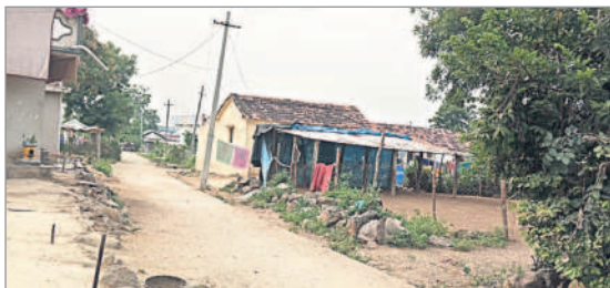
ఇటీవల గ్రామంలో నిర్మించిన సీసీ రోడ్డు
