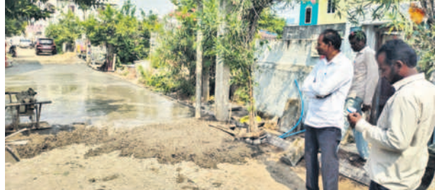
కూలీలైన్ సీసీ రోడ్డు నిర్మాణ పనులను పరిశీలించు డీఈ రవికుమార్
