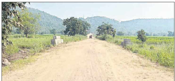
నాకాతండా వైపు పూర్తయిన ఫార్మేషన్ రోడ్డు పనులు
