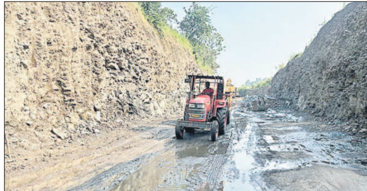
రఘునాథ్ పూర్ రాజుల ప్రాంతంలో పూర్తయిన రోడ్డు తవ్వకం పనులు
