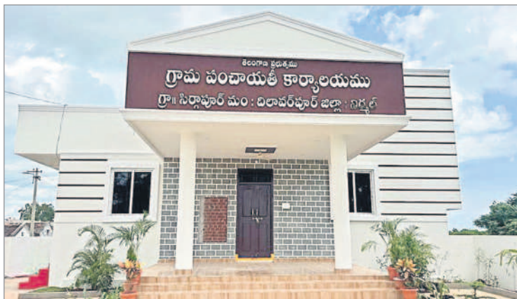
సిర్సాపూర్ మోడల్ గ్రామ పంచాయతీ భవనం
