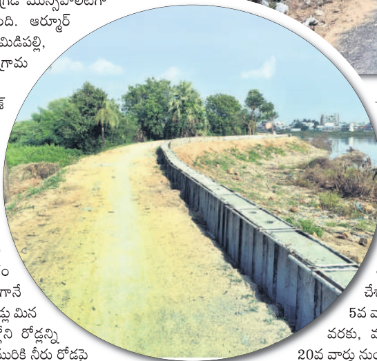
పెర్కిట్ ఊర చెరువు కట్టపై కొనసాగుతున్న మినీ ట్యాంకుబండ్ నిర్మాణ పనులు
