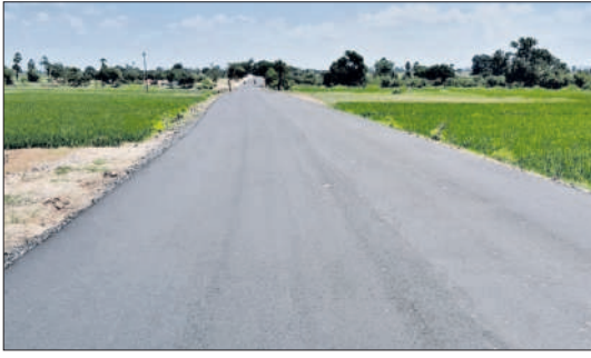
నేడు పూర్తయిన బీటీ రోడ్డు పనులు
