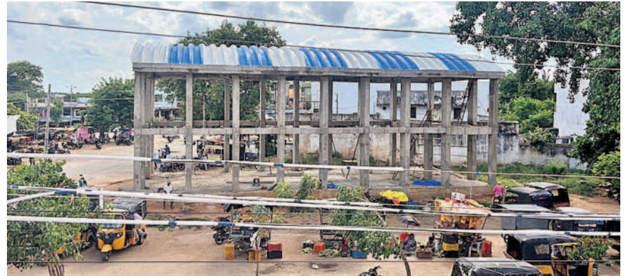
చేర్యాలలో కొనసాగుతున్న వెజ్, నాన్ వెజ్ మార్కెట్ భవన నిర్మాణ పనులు
