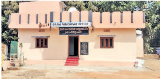
నూతనంగా నిర్మించిన రేగడిమైలారం జీపీ భవనం
