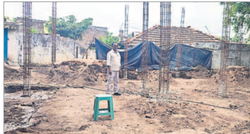
రేచిని జీపీలో కొనసాగుతున్న జీపీ భవన పనులు మరింత మెరుగ్గా పాలన...
