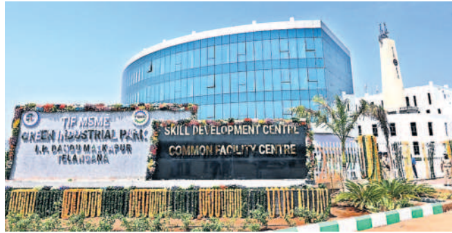
చౌటుప్పల్ మండలం దండుమల్కాపురం గ్రీన్ ఇండస్ట్రియల్ పార్కులో ఏర్పాటు చేసిన కామన్ ఫెసిలిటీ సెంటర్
