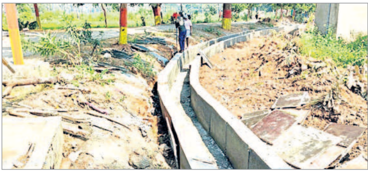
గ్రామంలో ఇటీవల నిర్మించిన డ్రైనేజీ నిర్మాణ పనులు
