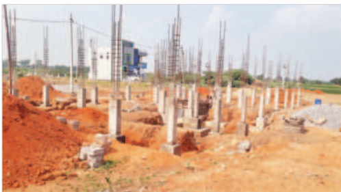
పిల్లర్ల నిర్మాణ దశలో కొనసాగుతున్న పనులు
