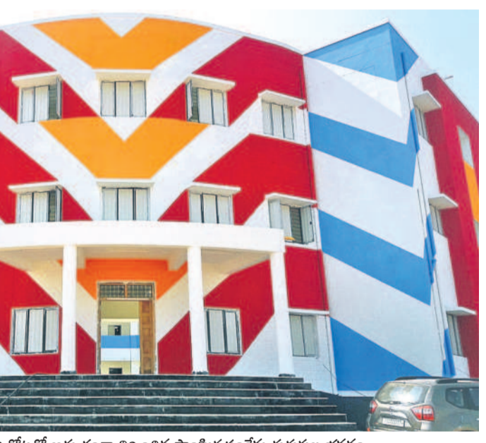
నారాయణ హాస్పిటల్ రూ. 19 కోట్లతో అద్భుతంగా నిర్మించిన సాంఘిక సంక్షేమ గుర్తుగా భవనం
