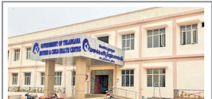
నారాయణపేటలో నిర్మించిన మాతాశిశు దవాఖాన
