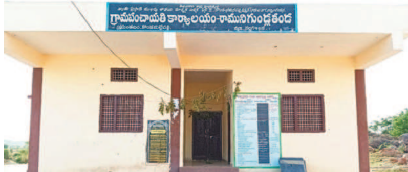
రామనిగుండ్లతండాలో నూతన నిర్మించిన పంచాయతీ భవనం
