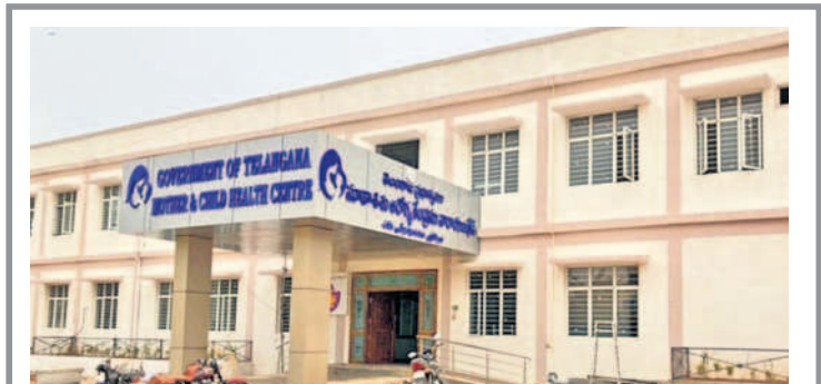
నారాయణపేటలో నిర్మించిన మాతాశిశు దవాఖాన
