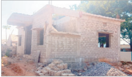
నూతనంగా నిర్మిస్తున్న గ్రామ పంచాయతీ భవనం
