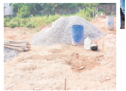
ధోబీఘాట్ నిర్మాణ పనులు
