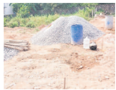
ధోబీఘాట్ నిర్మాణ పనులు
