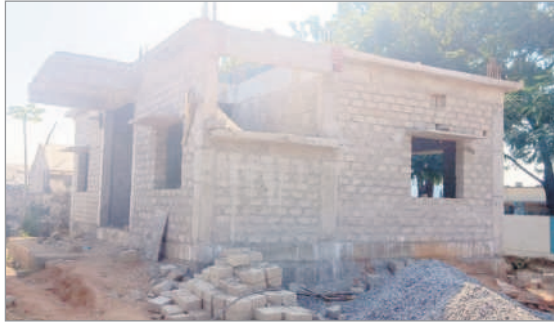
నూతనంగా నిర్మిస్తున్న గ్రామ పంచాయతీ భవనం
