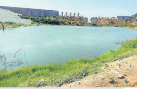
నిర్మాణంలో ఉన్న నక్కలగండి ప్రాజెక్టు కట్ట
