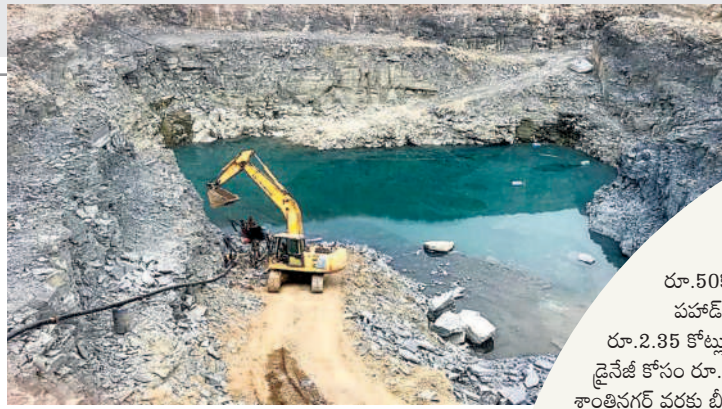
పాలకవీడు మండలం గుండ్లపహాడ వద్ద చురుగ్గా సాగుతున్న లిఫ్ట్ పనులు
