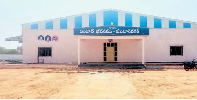
హజార్ నగర్ లో నిర్మించిన బంజారా భవన్
