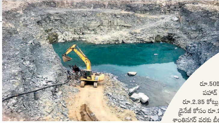
పాలకవీడు మండలం గుండ్లపహాడ వద్ద చురుగ్గా సాగుతున్న లిఫ్ట్ పనులు
