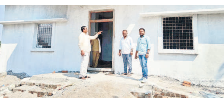
కంబాపూర్లో గ్రామ పంచాయతీ భవన నిర్మాణాన్ని పరిశీలిస్తున్న ఎంపీడీవో వెంకటేశ్వర్
