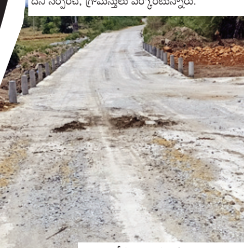
ఇటీవల పూర్తైన బ్రడ్డి నిర్మాణం
