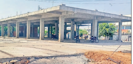
కమలాపూర్లో నిర్మాణంలో ఉన్న ఆర్డీసీ బస్టాండ్
