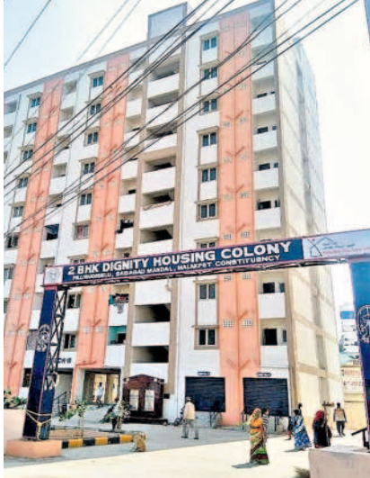
చంచల్ గూడ పిల్లిగుడిసెల వద్ద నిర్మించిన డబుల్ బెడ్ ఇండ్ల నిర్మాణ సముదాయం
