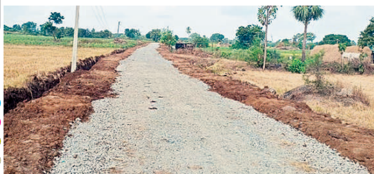
ప్రస్తుతం కొనసాగుతున్న తారు రోడ్డు నిర్మాణం పనులు
