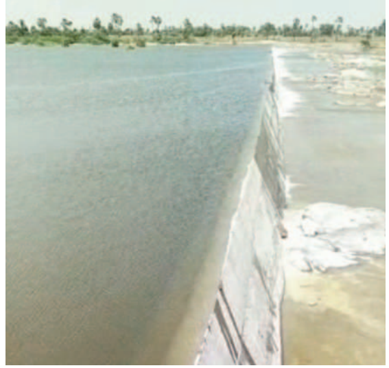
నీటితో కళకళలాడుతున్న మూసీవాగుపై రావులపెంట వద్ద నిర్మించిన చెక్ డ్యామ్
