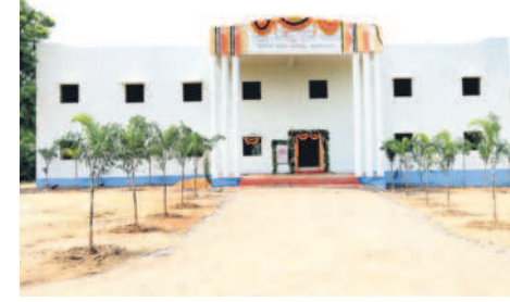
మండలంలో నిర్మించిన 'సమ్మక్క-సారలమ్మ' మహిళా భవన
